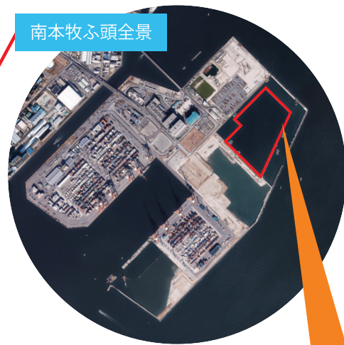
南本牧第5ブロック廃棄物最終処分場
