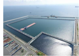
南本牧廃棄物最終処分場 （第5ブロック）
